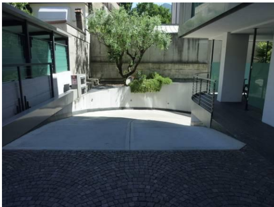
Rampa d'accesso ai piani interrati
