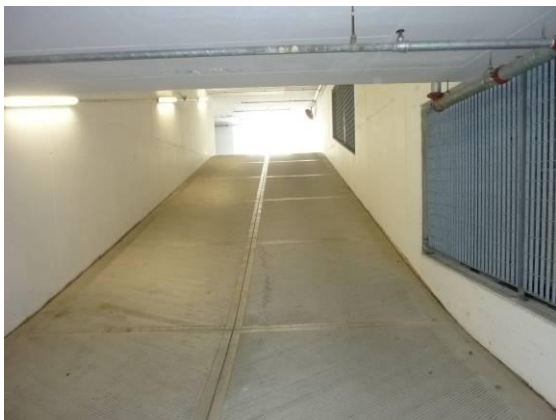
Rampa d'accesso piani interrati
