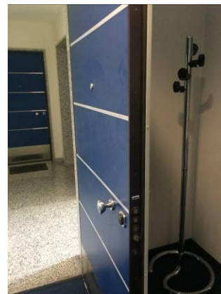
Portoncino d'ingresso dal vano scale
