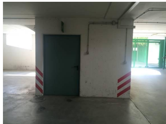
Accesso vano scala P.M. 1
