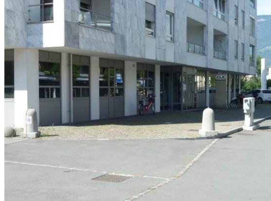
Particolare prospetto nord uffici
