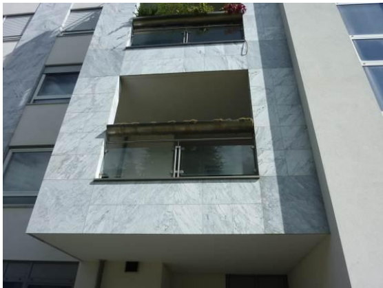
Prospetto sud, particolare balcone ufficio al 1. piano
