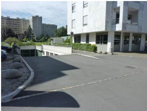
Rampa accesso piano interrato
