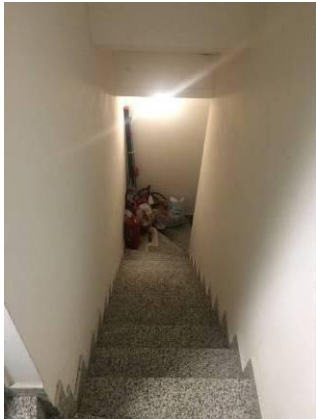
Scala accesso piano interrato
