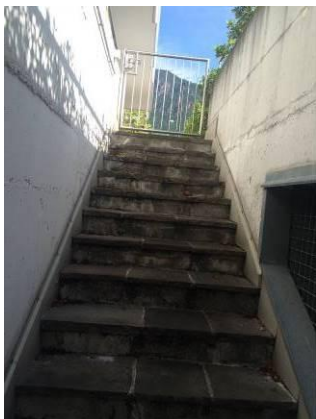
Scala accesso piano interrato
