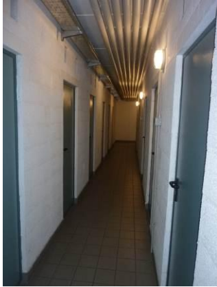
Piano interrato – corridoio comune cantine
