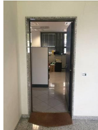
Accesso dal vano scale
