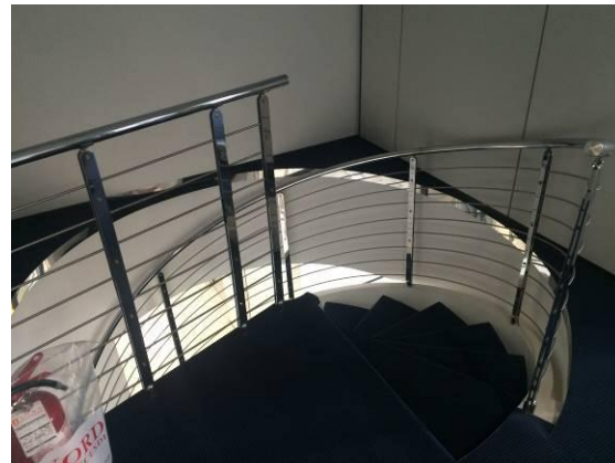
Scala d'accesso primo piano
