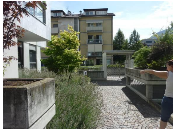
Camminamento comune di accesso
