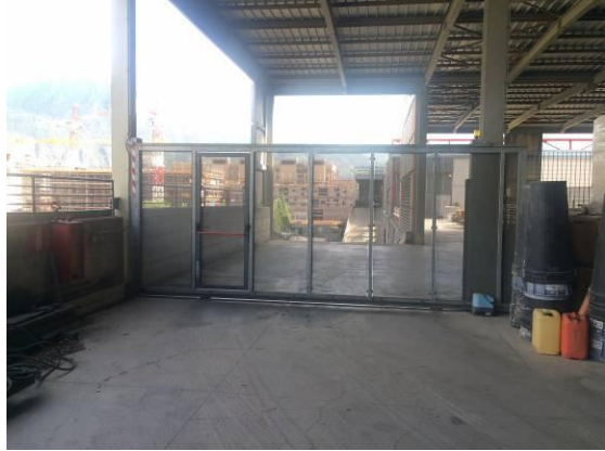
Cancello di accesso al piano primo
