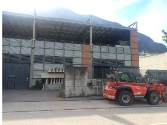
Accesso al piano terra
