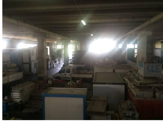
Vista interna dalla scala
