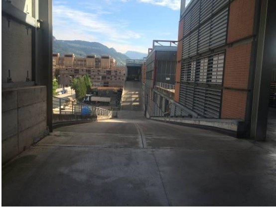
Rampa d'accesso deposito piano primo
