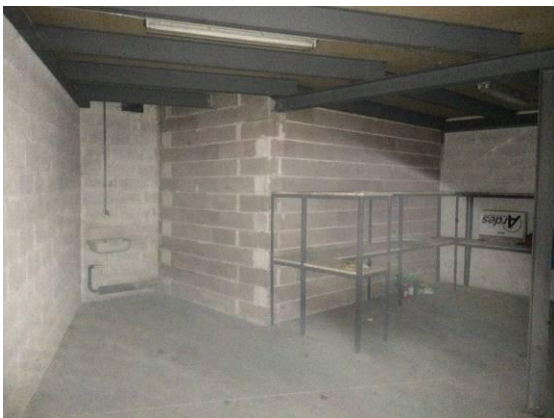
Magazzino con vista piccolo deposito con accesso dalla corsia di manovra
